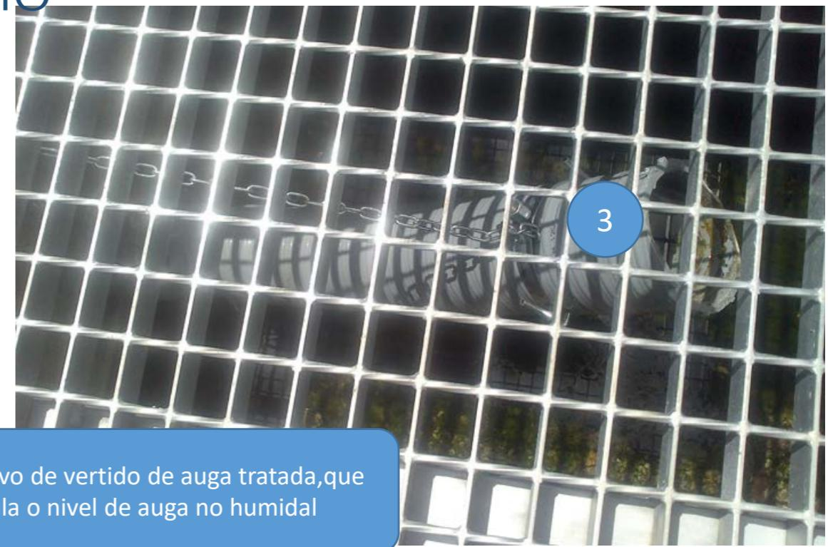
Dispositivo de vertido de auga tratada, que regula o nivel de auga no humidal
